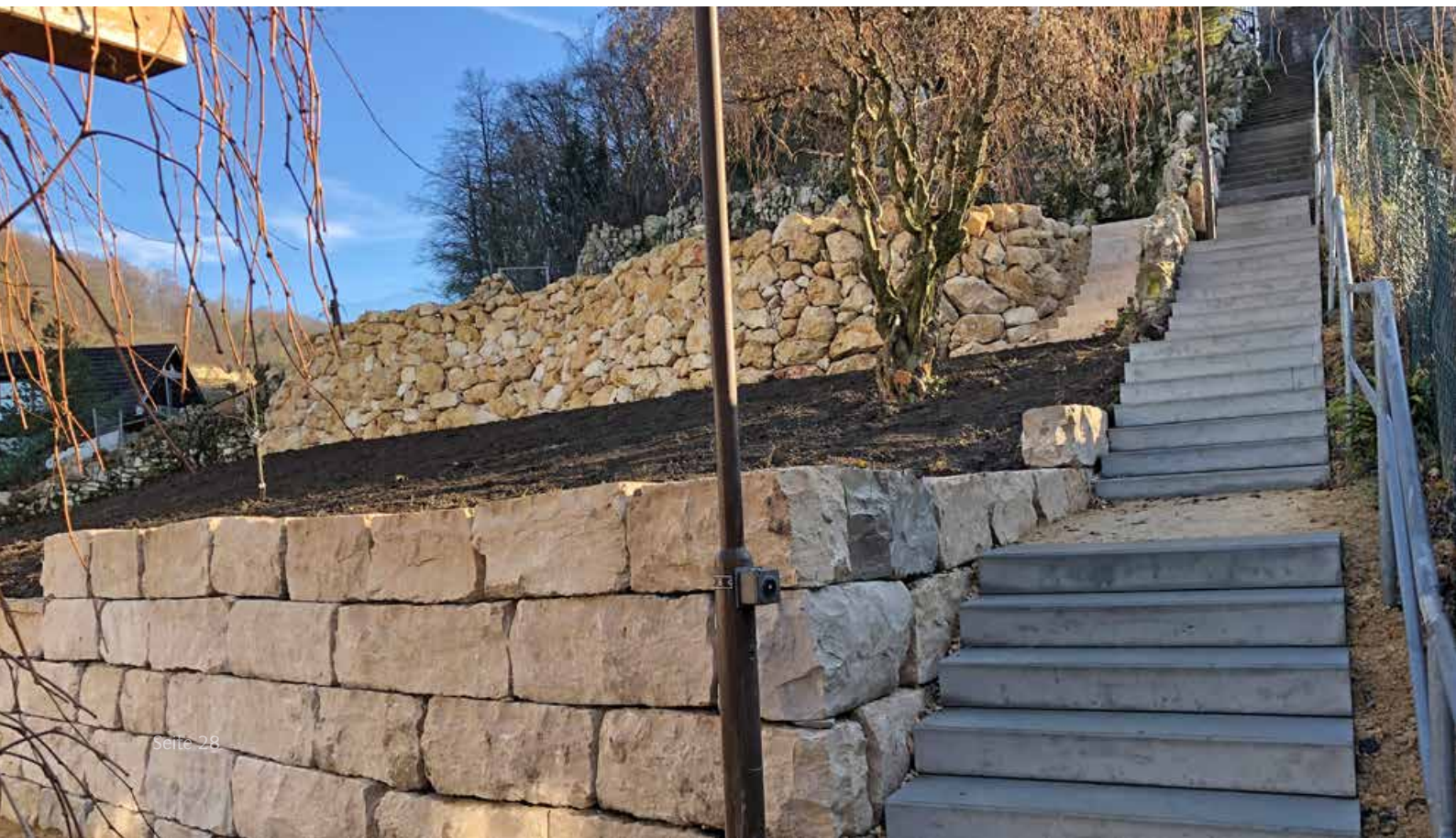
Die frisch sanierte Stützmauer im Pfarrgarten in Buus.
