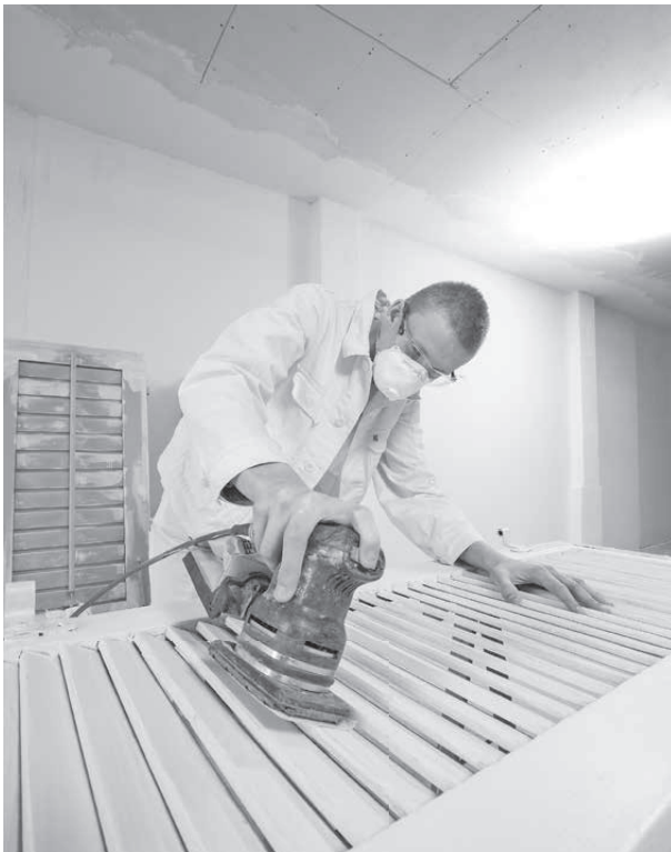
Arbeiten in der Werkstatt Baubetriebe.
