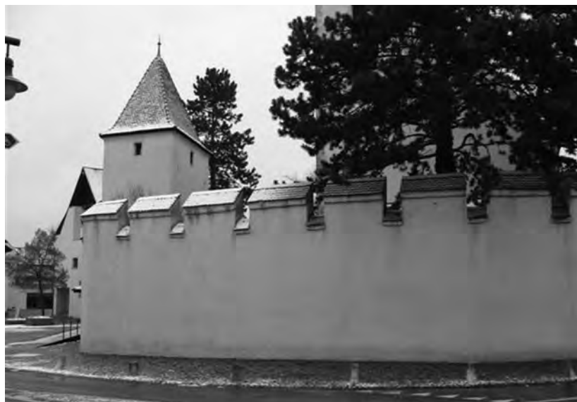
Die frisch renovierte Ringmauer in MuttENZ.
