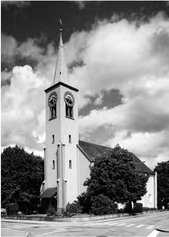
Die 1960 umgebaute Birsfelder Kirche mit abgeändertem Turm und Dach sowie zugemauerten gotischen Bogenfenstern im Schiff.
